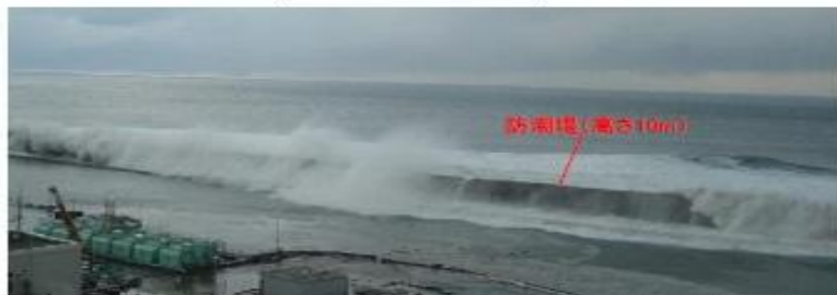
【福島第1原発 津波被害状況 2011年3月11日 国体産業物産館東側のり面(6号機の近傍)から東側を撮影】=東京電力提供
