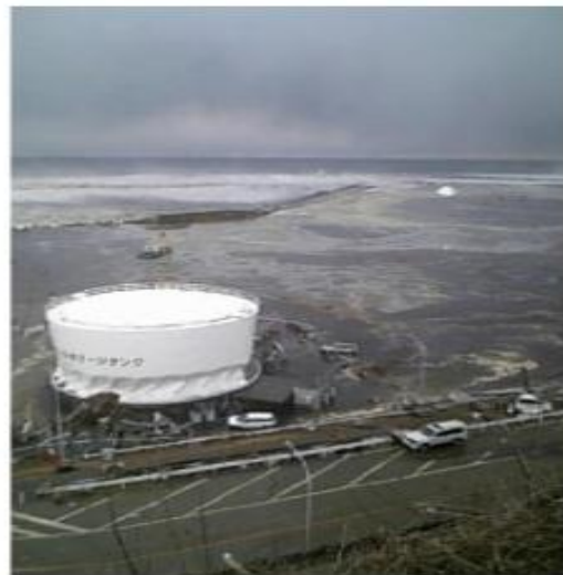
【福島第1原発 津波被害状況 2011年3月11日 国体産業物産館東側のり面(6号機の近傍)から東側を撮影】=東京電力提供
